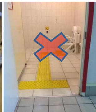
Фото 1, фото 2 – маршрут движения инвалида по зрению, выполненный в виде наклеенных на поверхность тактильных ПВХ плиток с различным рисунком (риффы в шахматном порядке, диагональные риффы, параллельные риффы).
